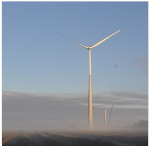
3.4.14. un 3.4.15. attēls. Saliekamie betona torņi vēja parkā "Laflora" (avots: Consolis Latvija SIA)
